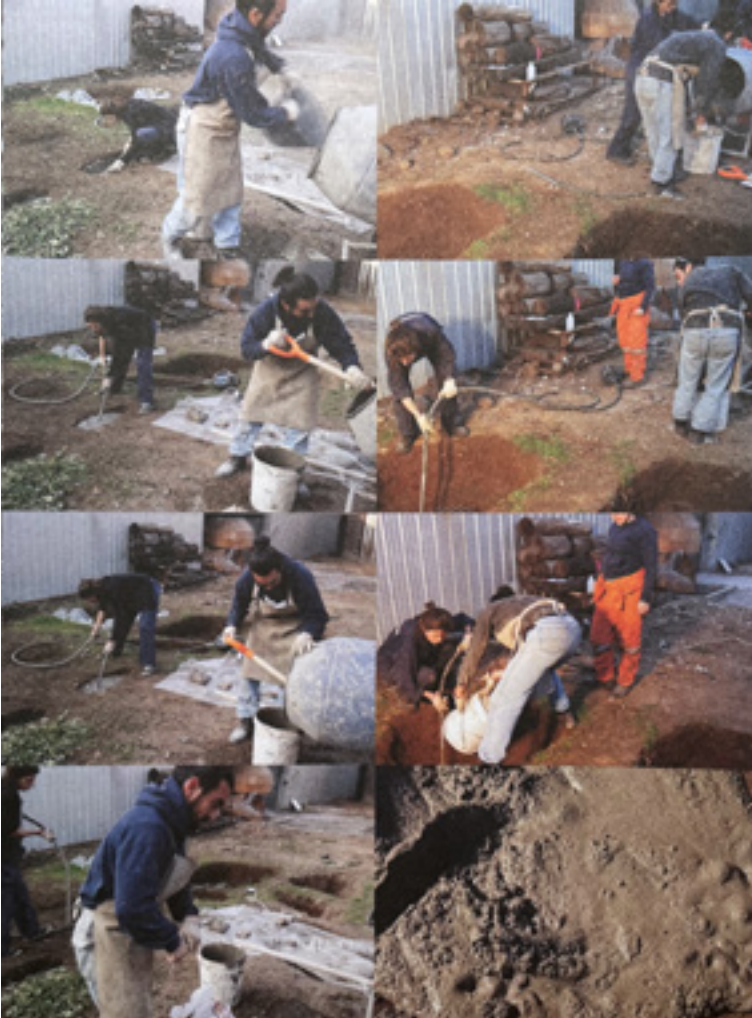
Figura 2. Francisca Sánchez, Tabla Rasa . Processo de escavação e construção do trabalho.
