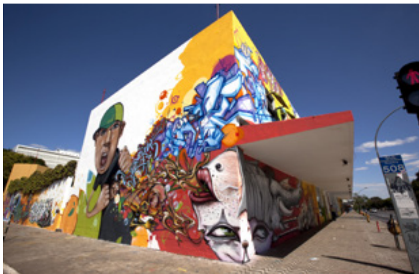
Figura 4. Detalhe das paredes grafitadas na via W3.
