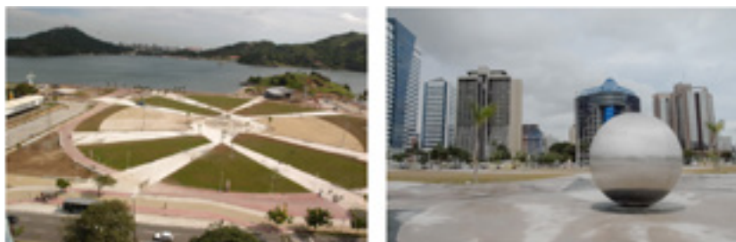
Figura 1. Praça durante sua construção e conclusão da obra. Verifica-se que a Rosa dos Ventos é o marco principal e configura praticamente toda a praça.
